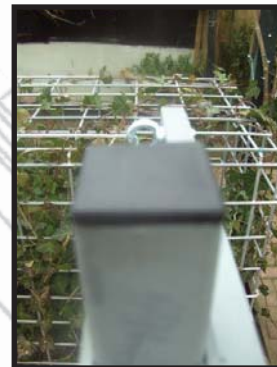
Die offenen Enden sind mit Kunststoffkappen geschlossen.
