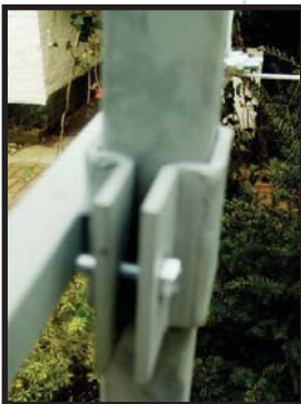
Befestigung von der U-Rinne, sowie die Querstange ist verstellbar auf irgendeiner Höhe.
